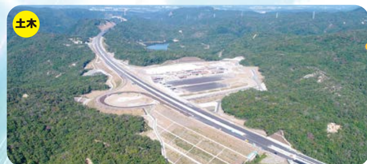
新名神高速道路(宝塚SA~切畑トンネル) 兵庫県
