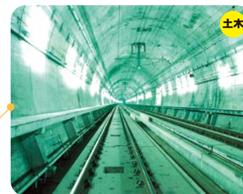
青函トンネル(吉岡工区) 北海道松前郡福島町
