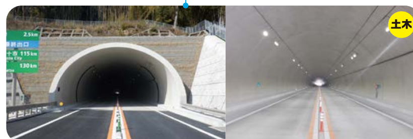
五台山トンネル 高知県
